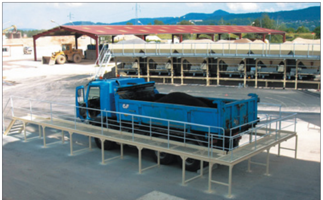
Photo 3.7 Passerelle arrière fixe.
