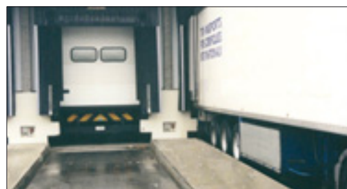
Photo 3.4 Quai aménagé avec guide-roues, rampe ajustable sur quai, butoirs assurant un espace de 500 mm, prises électriques pour groupe frigorifique avec passage pour le hayon en partie inférieure.
