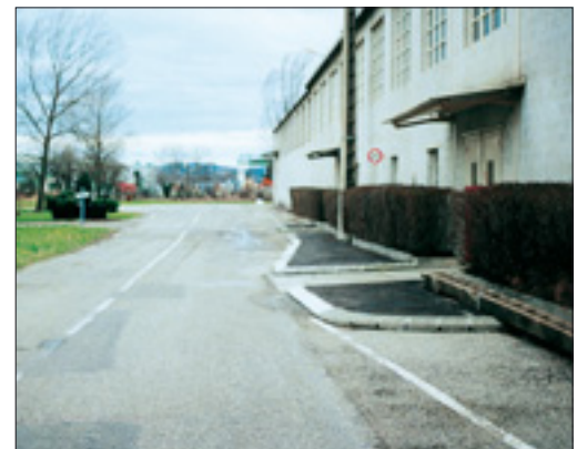
Photo 3.3 Écarteur de circulation au droit d'un débouché de porte.
